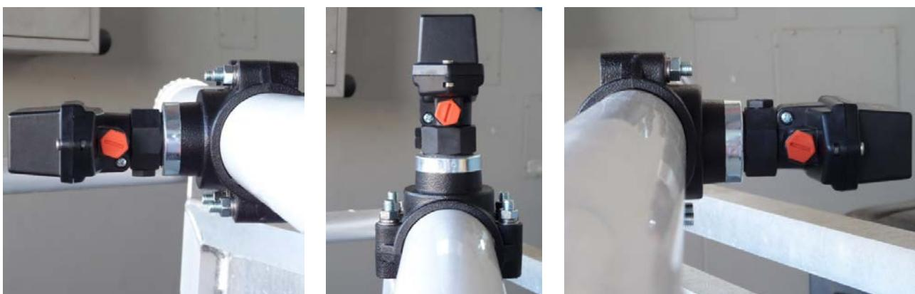
O interruptor de caudal não deve ser montado na parte inferior dos tubos horizontais.
