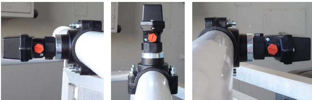
Il flussostato non deve essere installato sul lato inferiore di tubi orizzontali.
