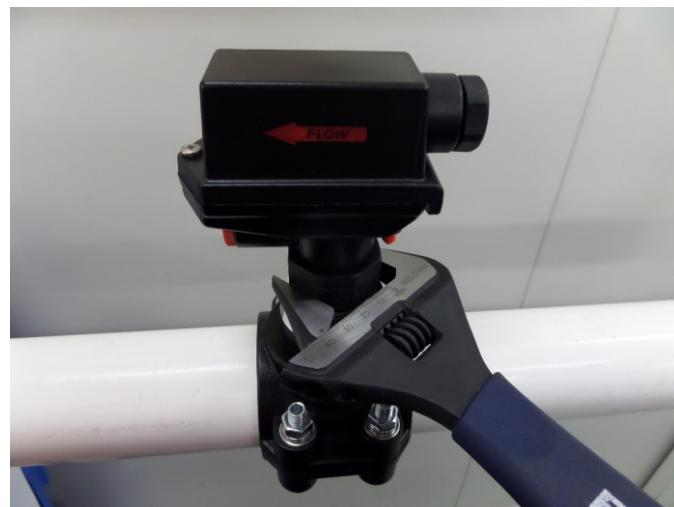
O alinhamento do interruptor é crítico para corrigir a operação. O interruptor deve estar alinhado com o tubo e a seta do caudal na direção do caudal. Retire a tampa do quadro elétrico e introduza os cabos na entrada de cabos. Ligue os cabos aos terminais identificados como “COMM” e “NO”.
