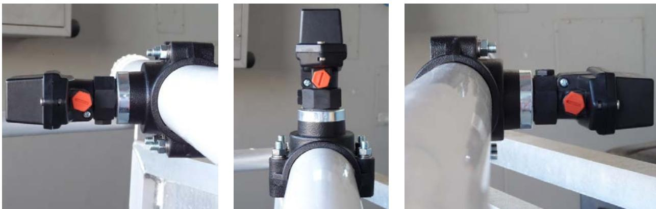
L'interrupteur de débit ne doit pas être positionné sur la face inférieure des tuyaux horizontaux.
