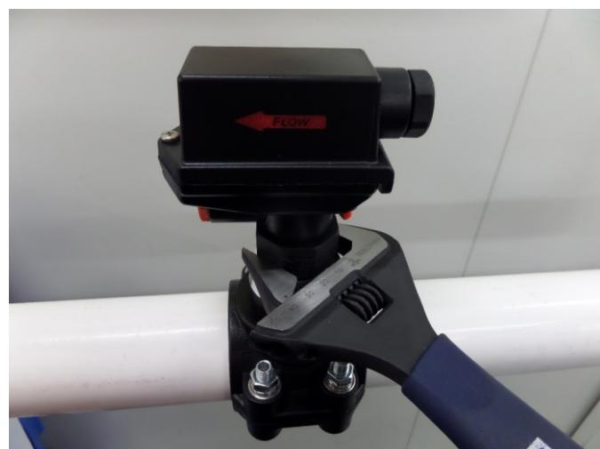
La alineación del interruptor es vital para un funcionamiento adecuado. El interruptor debería estar alineado con la tubería y la flecha de flujo situada en el sentido del flujo. Retire la tapa de la caja eléctrica e inserte los cables en la entrada para cables. Conecte los cables a los terminales marcados como «COMM» y «NO».
