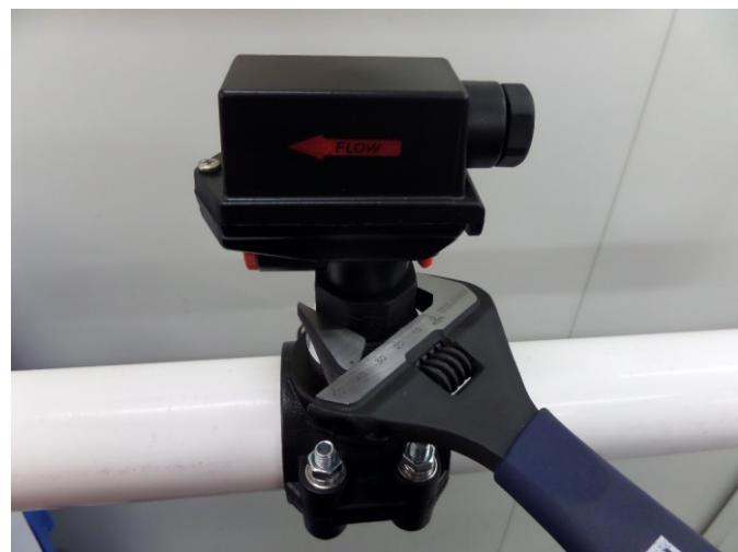
L'allineamento del flussostato è fondamentale per un funzionamento corretto. Il flussostato deve essere allineato con la tubazione e con la freccia relativa al flusso nella direzione del flusso. Rimuovere il coperchio dell'armadio elettrico e inserire i cavi nell'ingresso per i cavi. Collegare i cavi ai terminali etichettati "COMM" e "NO".
